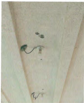
Foto 1: Reparación de Sistema eléctrico
